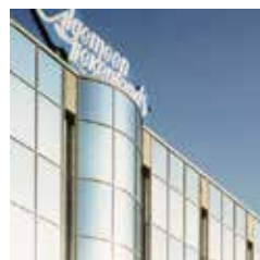
Foto 1 PanHolite glaspanelen te Breda.
