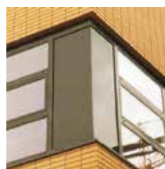
Foto 6 Geëmailleerde PanHolite panelen te Duivendrecht.
